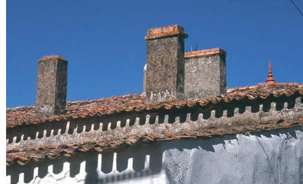
Tuiles canal, rives saintongeaises, souches maçonnées, mitres en briques et épis de faitage, Saint-Sornin
