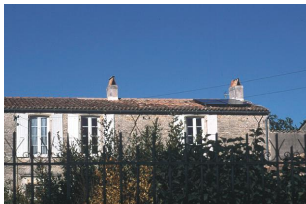
Capteurs solaires sur toiture ancienne
