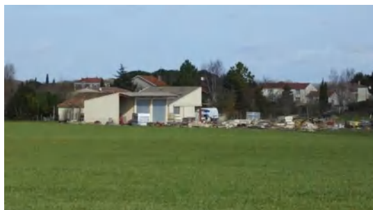
Depôt sans intégration paysagère. Point noir important sur cette entrée de bourg. La création de vergers ou de haies permettrait d'atténuer l'impact du dépôt
