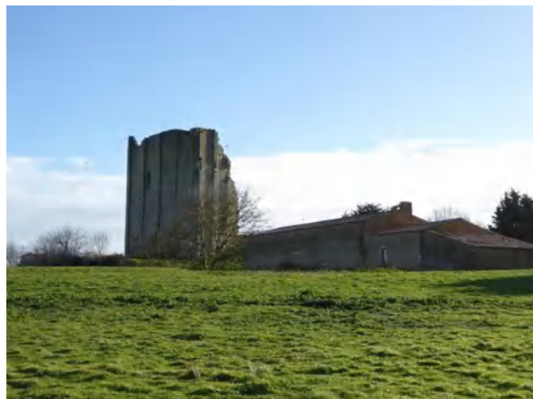
Vue sur la tour de Broue
