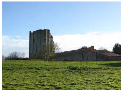
Vue sur la tour de Broue
